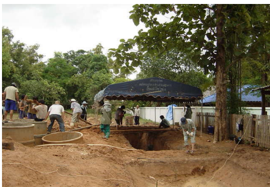
掘削工事の様子。テントは雨よけ、日除け用。
